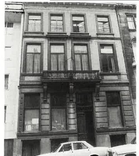
ガシヤールの旧校舎
